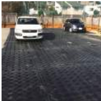
プラスチック敷板
