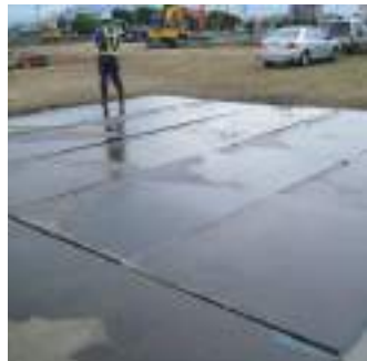
養生用敷鉄板
